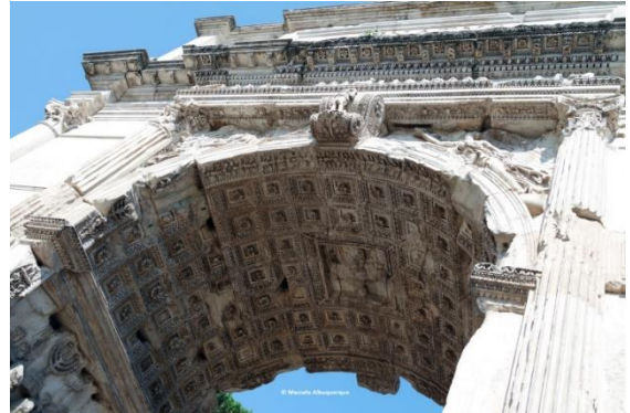
Abóbada de berço em concreto romano do Arco de Tito, Roma.
